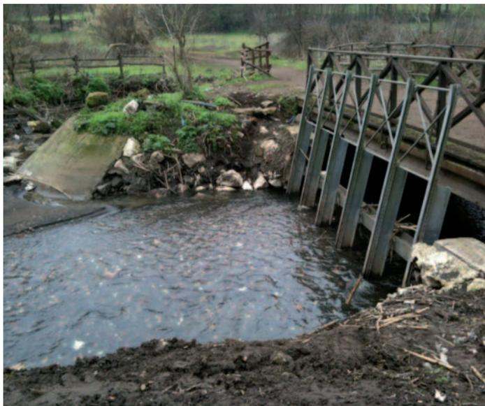
La griglia di contenimento delle discariche trasportate dalle piene del fiume presso Via dell'Almone.
