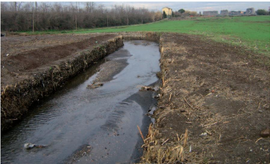
**FIGURA 84** La risagomatura del Fosso della Patatona o Calicetto. (Foto R. Federici).
